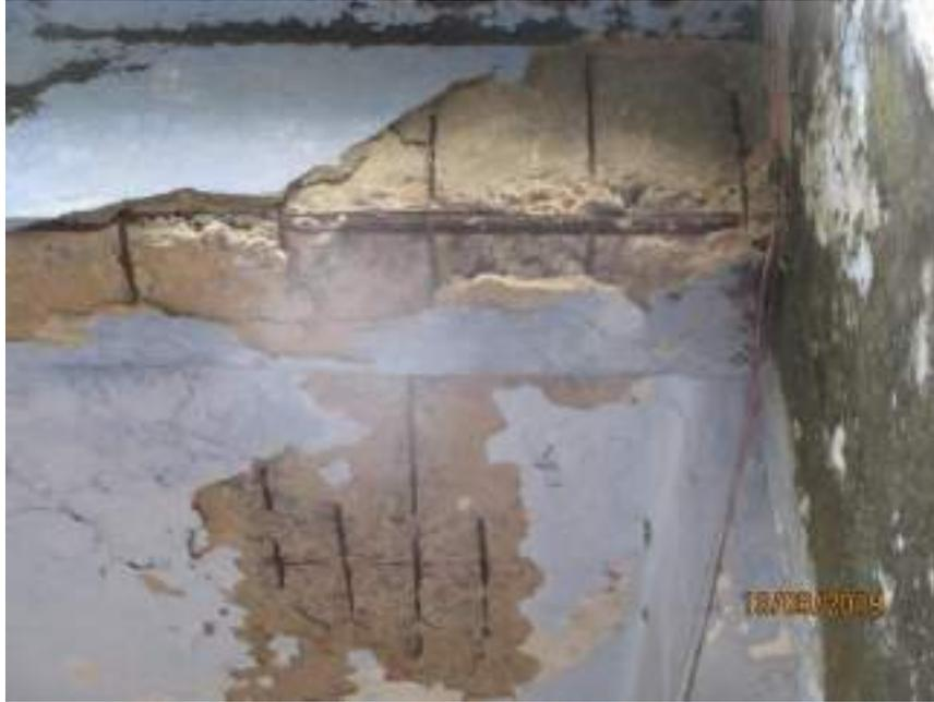
**Fig. 28. Dead Condition of stirrups in a beam**
